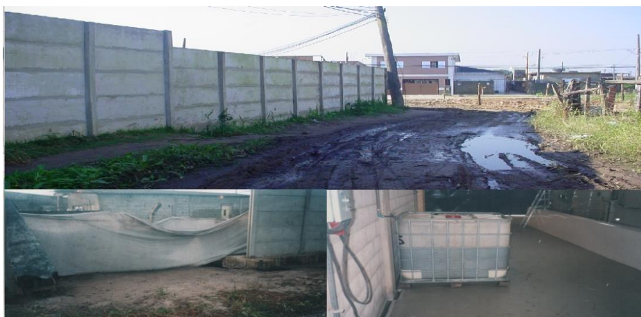
Figura 32 - Muro e o recipiente onde foram depositados os resíduos encontrados
