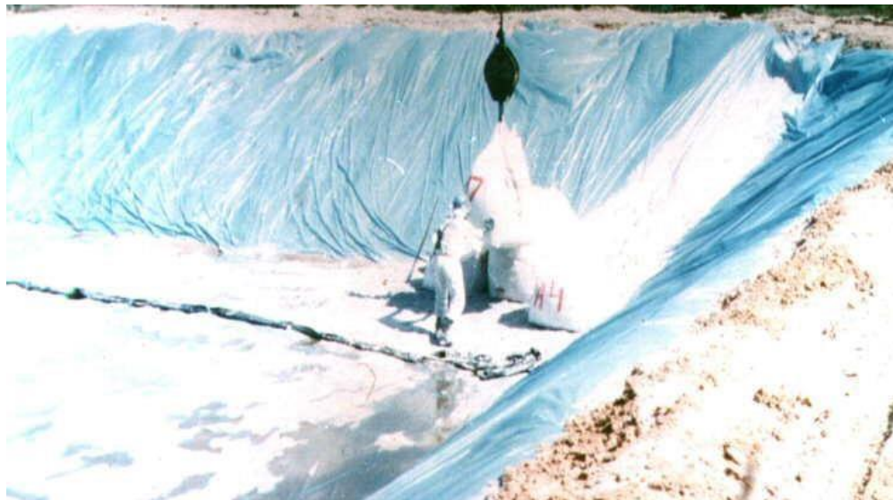
Figura 7 - Estação de espera em São Vicente, início da estocagem de resíduos
