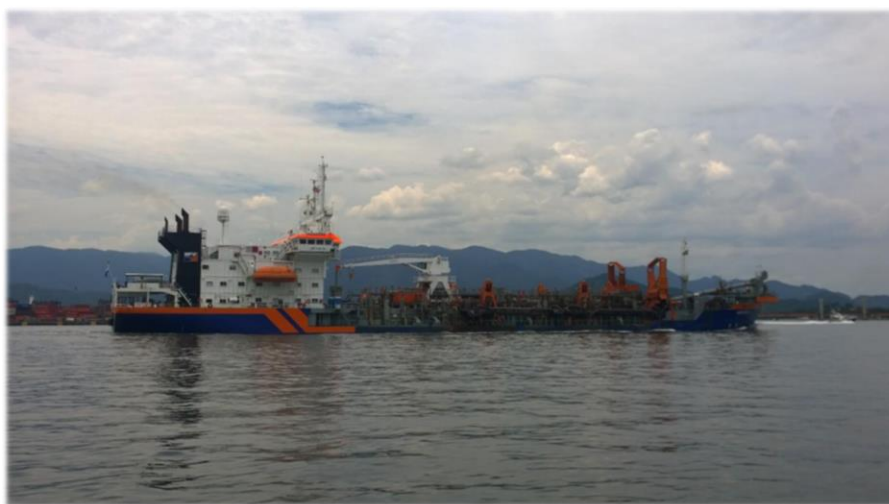
Foto 01 – Dragagem em Operação no dia da Amostragem (10/01/2017)
