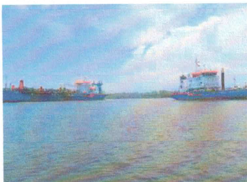
Figura 3 – Operações de dragagem para construção da cava subaquática sendo realizada na área de expansão portuária.
