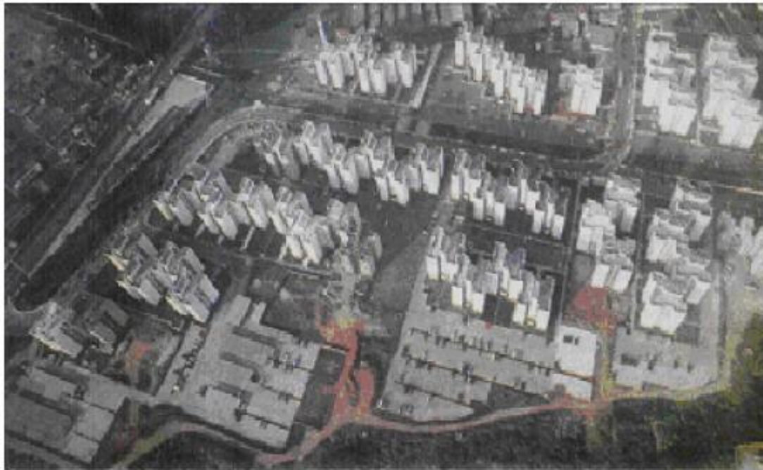
Foto V-1: Visão geral do Conjunto Residencial Barão de Mauá
