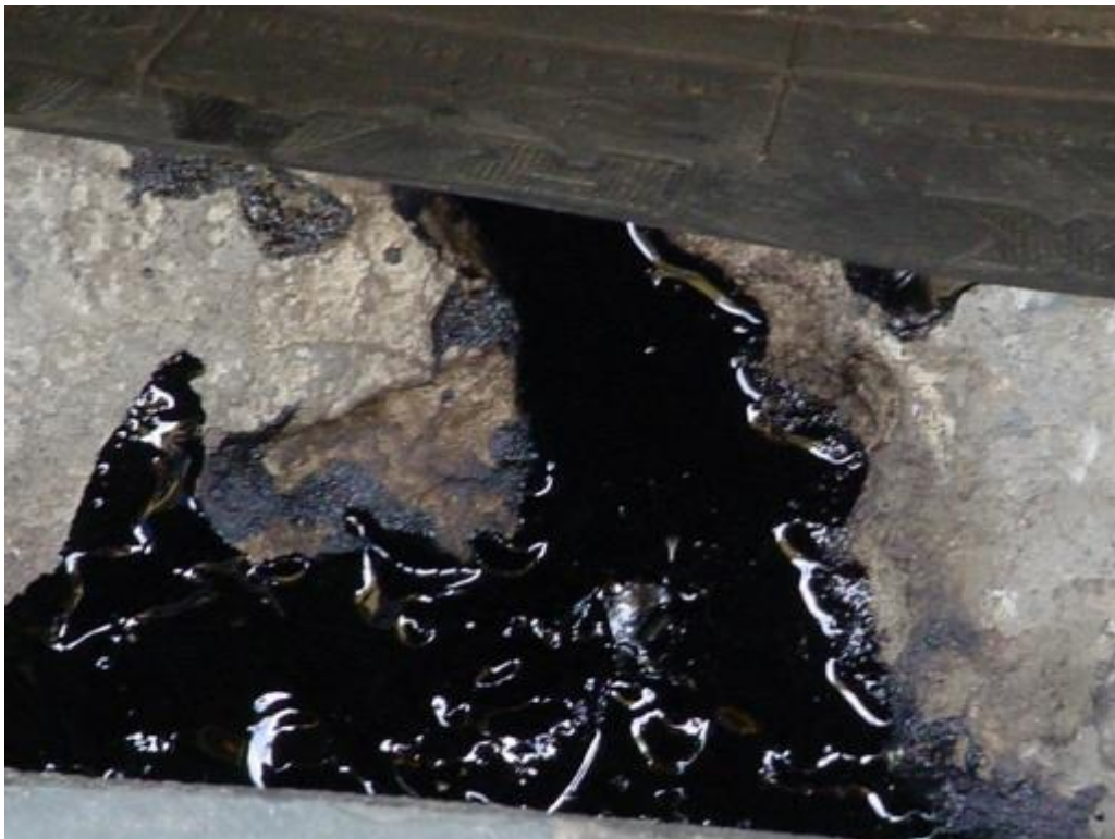
Imagem 8 - Afloramento de material suspeito no meio fio da rua do bairro
